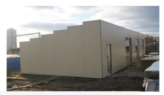
**№4.** Монтаж кровельных и стеновых сэндвич панелей с доборными элементами.
